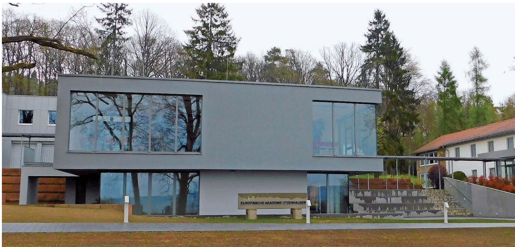
Der jüngste Neubau an der Europa-Akademie in Otzenhausen ist fertiggestellt. Somit sind nun alle Sanierungsarbeiten abgeschlossen.
